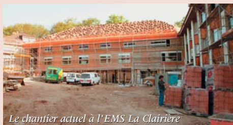
Le chantier actuel à l'EMS La Clairière
