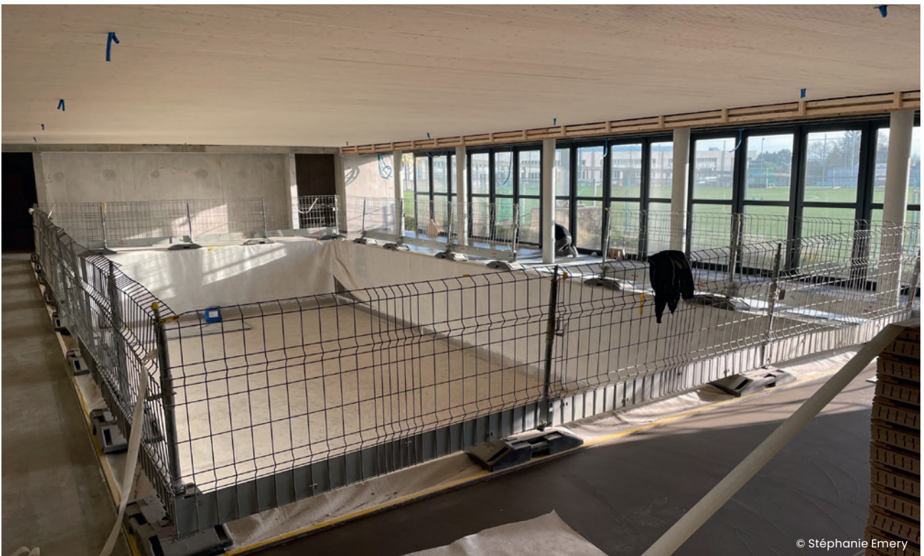
Bassin d'apprentissage en cours de construction
