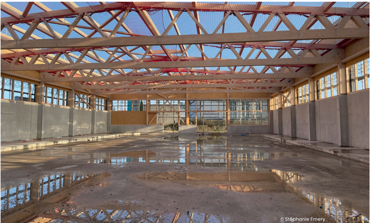
Patinoire en cours de construction
